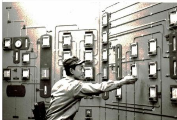
第2常圧蒸留装置の計器操作パネル
