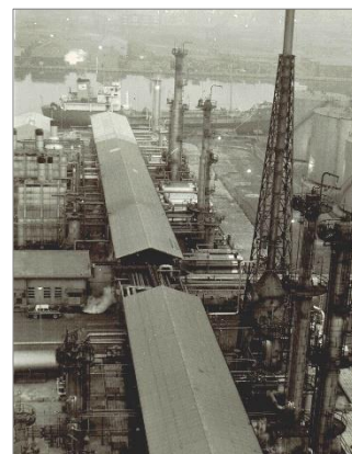
第 2 常圧蒸留装置の蒸留塔頂部 から装置を望む
