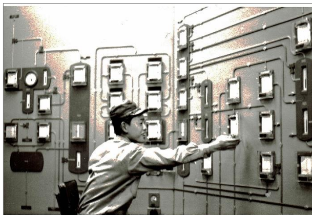
第 2 常圧蒸留装置の計器操作パネル (昭和 38 年)
