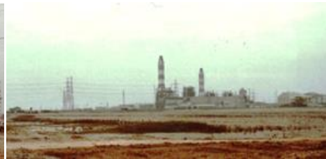
仮設事務所から中電知多火力発電所を望む
