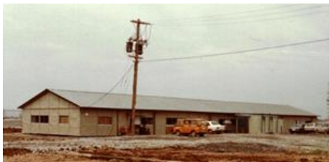
仮設建設事務所
